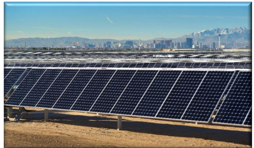
Nellis Solar Array II
